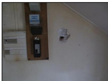
Photo N° 36 ECH-N°030 Salle 1 +1 Murs Plâtre + peinture
