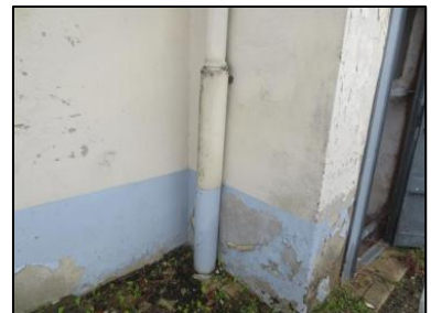
Photo N° 58 ECH-N°049 AMIANTE CIMENT Cour Conduites d'eaux (Fibres-ciment)
