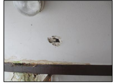
Photo N° 50 ECH-N°043 Escalier vers +1 Plafond Plâtre + papier peint + peinture
