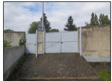
Photo N° 60 ECH-N°050 Cour Mur Rue Béton + peinture
