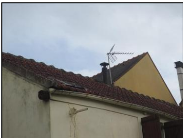
Photo N° 59 ECH-N°049 AMIANTE CIMENT Maison Conduits de cheminées Cheminée (Fibres-ciment)
