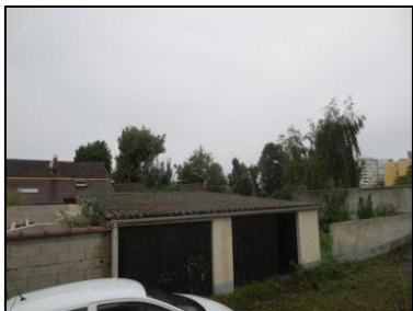
Photo N° 55 ECH-N°047 AMIANTE CIMENT 2 Garages Toiture Toiture ondulée (Fibres-ciment)
