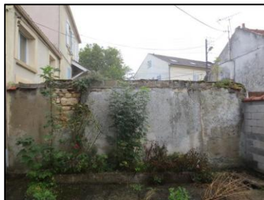
Photo N° 65 ECH-N°055 Cour Mur face Béton
