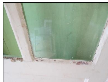
Photo N° 28 ECH-N°022 Rdc - Salle 2 Joint - Porte Mastic
