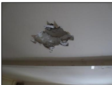
Photo N° 37 ECH-N°029 Salle 1 +1 Plafond Polystyrène + plâtre + papier peint + peinture
