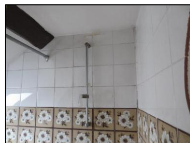
Photo N° 44 ECH-N°037 Salle d'eau +1 Murs Colle faïence blanche
