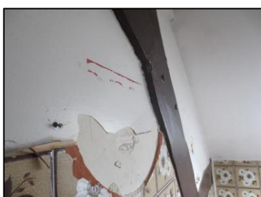
Photo N° 45 ECH-N°038 Salle d'eau +1 Murs Plâtre + peinture
