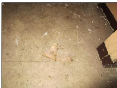
Photo N° 42 ECH-N°035 REVETEMENT DE SOL Entrée +1 Plancher Mortier + colle + linoléum
