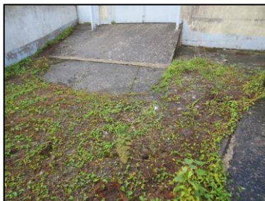
Photo N° 62 ECH-N°052 Cour Plancher Béton
