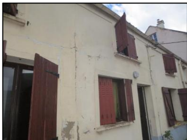
Photo N° 64 ECH-N°054 Maison Mur façade Béton + peinture
