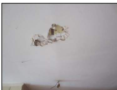
Photo N° 21 ECH-N°015 Rdc - Salle 1 Plafond Plâtre + papier peint + peinture
