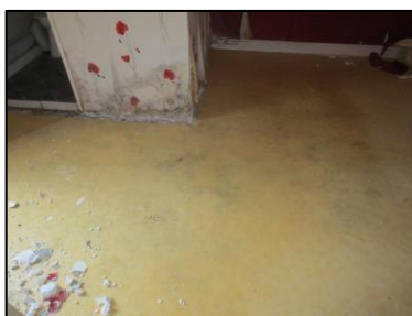
Photo N° 18 ECH-N°012 REVETEMENT DE SOL Rdc - Salle 1 Plancher Béton + colle + linoléum
