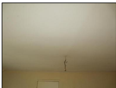
Photo N° 10 ECH-N°008 Rdc - Cuisine Plafond Polystyrène + plâtre + peinture
