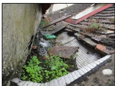
Photo N° 67 ECH-N°056 Maison Etanchéité toiture Etanchéité type "paxalu"
