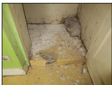
Photo N° 29 ECH-N°023 REVETEMENT DE SOL Rdc - Débarras Plancher Béton + colle + linoléum
