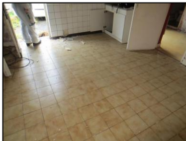
Photo N° 6 ECH-N°001 REVETEMENT DE SOL Rdc - Cuisine Plancher Colle carrelage
