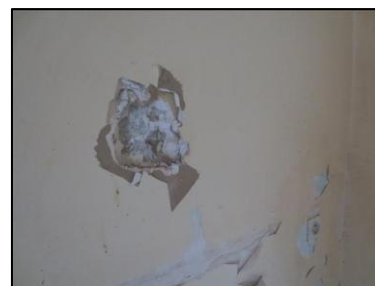
Photo N° 16 ECH-N°006 Rdc - Cuisine Mur gauche Béton + plâtre + peinture
