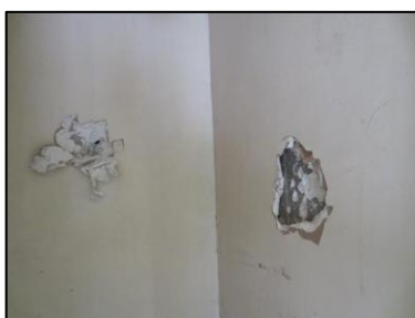
Photo N° 30 ECH-N°024 Rdc - Débarras Mur droite Plâtre + peinture
