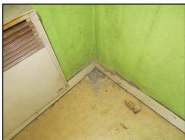
Photo N° 26 ECH-N°020 REVETEMENT DE SOL Rdc - Salle 2 Plancher Béton + colle + linoléum
