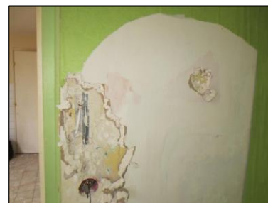
Photo N° 25 ECH-N°019 Rdc - Salle 2 Murs Plâtre + papier peint + peinture
