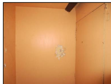
Photo N° 41 ECH-N°034 Entrée +1 Murs Mortier + plâtre + peinture
