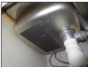
Photo N° 12 ECH-N°011 Rdc - Cuisine Revêtement sous évier Bitumineux
