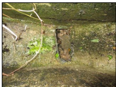
Photo N° 74 ECH-N°057 AMIANTE CIMENT Cour Conduites d'eaux dans le regard (Fibres-ciment)
