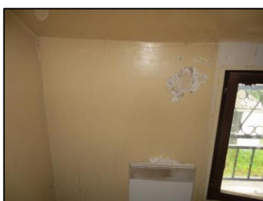
Photo N° 34 ECH-N°026 Cuisine +1 Mur Polystyrène + plâtre + papier peint + peinture
