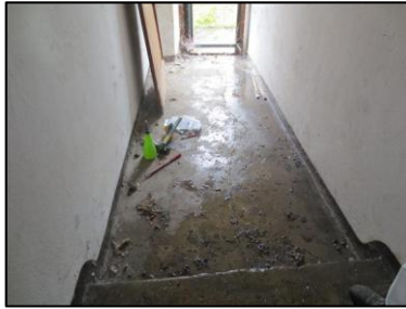
Photo N° 53 ECH-N°045 Rdc - Entrée vers logement +1 Plancher Béton
