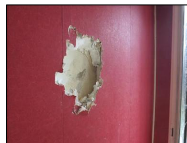
Photo N° 19 ECH-N°013 Rdc - Salle 1 Mur entrée Béton + plâtre + polystyrène + peinture
