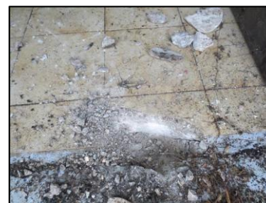
Photo N° 13 ECH-N°002 Rdc - Cuisine Plancher Béton
