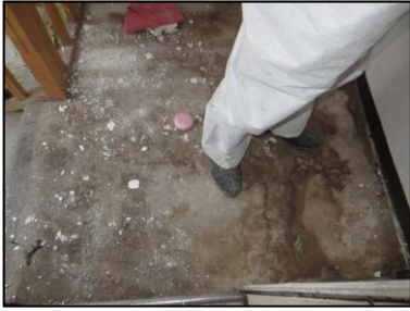
Photo N° 48 ECH-N°041 REVETEMENT DE SOL Palier +1 Plancher Béton + colle
