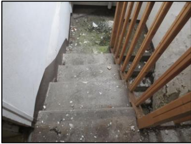
Photo N° 51 ECH-N°044 REVETEMENT DE SOL Escalier vers +1 Marches Béton + peinture
