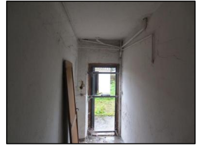
Photo N° 54 ECH-N°046 Rdc - Entrée vers logement +1 Murs Plâtre + peinture
