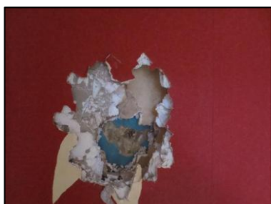
Photo N° 20 ECH-N°014 Rdc - Salle 1 Mur droite Béton + plâtre + polystyrène + peinture
