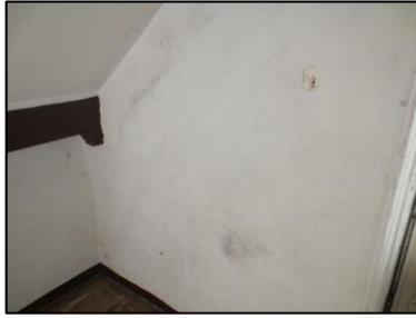
Photo N° 49 ECH-N°042 Palier +1 Murs Plâtre + peinture
